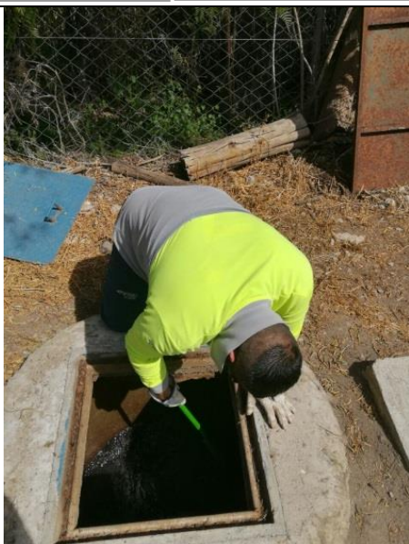
Limpieza cámara anterior a canaleta Parshall
